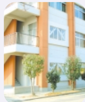
校舎を鉄骨の「筋かい」で補強（洛水高校）
